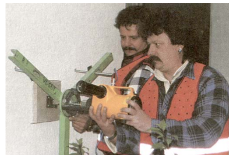
Фото 1. Полевой контроль прочности сцепления WDVS с основанием ограждения[27].
