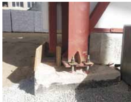
Рис.4. Устранение допущенной ошибки при монтаже с помощью клеевых анкеров
