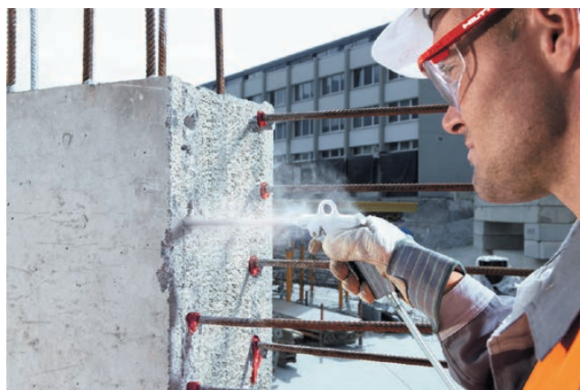
Продувка отверстия для вклейки арматурных стержней
